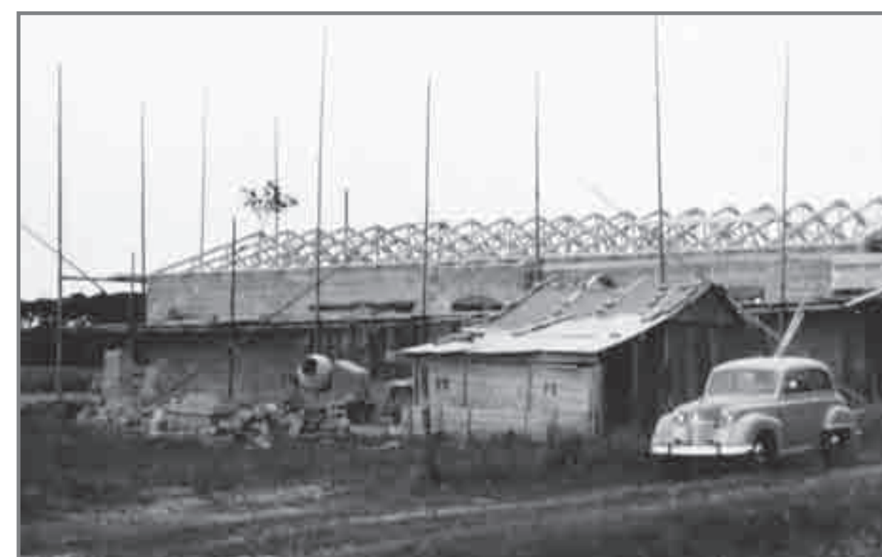
Der Rohbau des Schützenhauses steht
