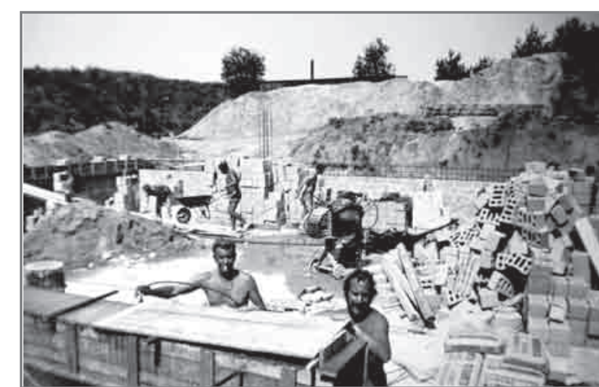
Gerhard Hartmann u. Hartmut Knapp – Bau der 10-Meter Standanlage
